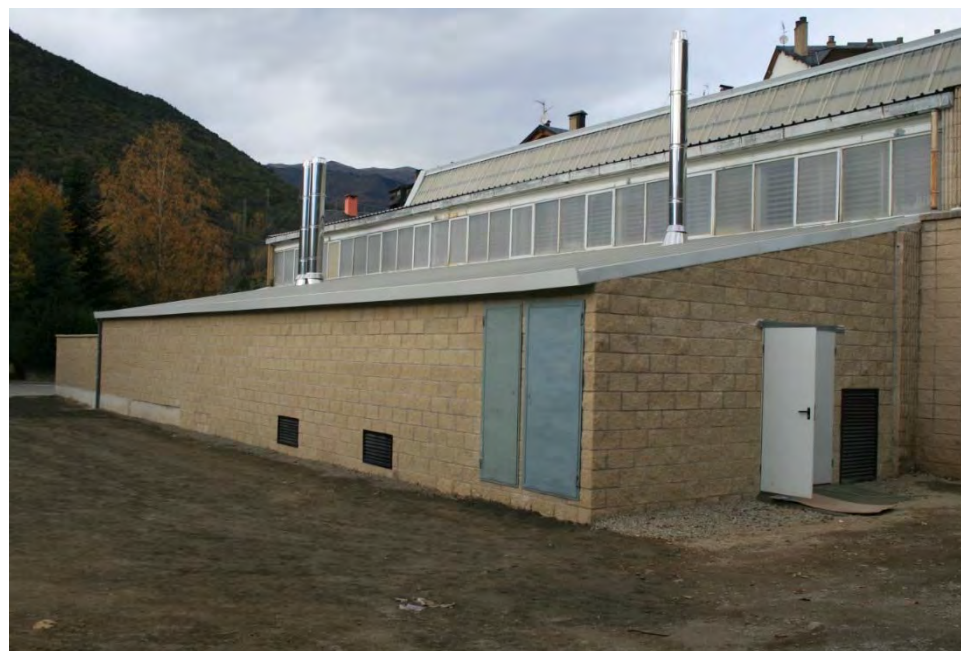
EXTERIOR SALA DE CALDERAS
