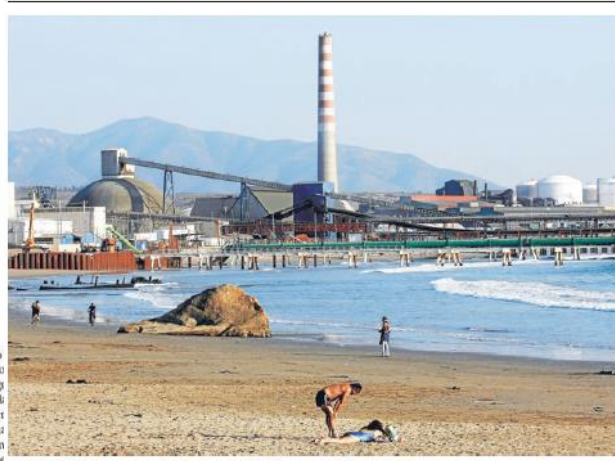
► La fundición Ventanas está ubicada en la V Región, cerca de Puchuncaví. FOTO: RODRIGO CISTERNAS
