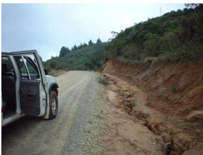
En los sectores de pendiente (accesos a cerro Teta Sur), el camino en su borde interior ha sufrido una fuerte erosión del terreno por socabamiento, debido a que no existe canaletas de desagüe de lluvias. Estas profundas cárcavas formadas han sido utilizadas por los pobladores y transeúntes, quienes disponen sus residuos sólidos formándose así microbasurales.
